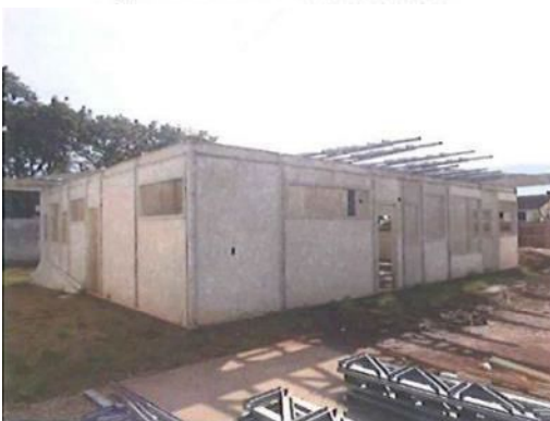
Figura 22: Bloco de Serviços
