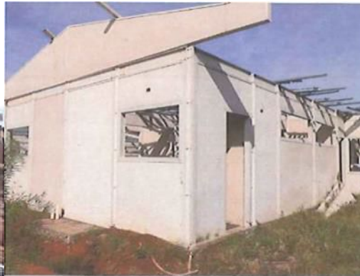
Figura 23: Bloco de Serviços
