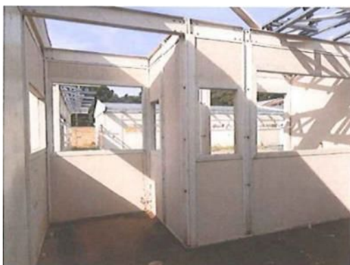
Figura 24: Bloco de Serviços
