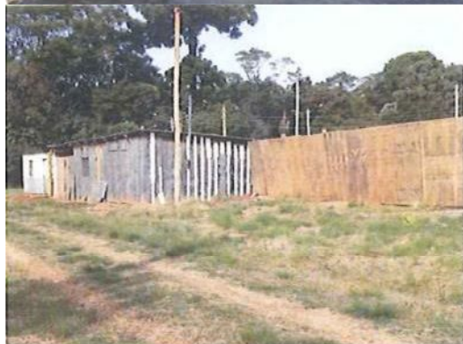
Figura 4 - Barracão de obra invadido - mai/2017
