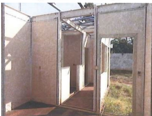
Figura 26: Bloco de Serviços
