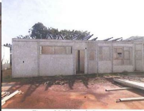
Figura 21: Bloco de Serviços
