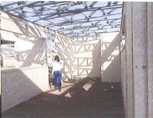
Figura 25: Bloco de Serviços
