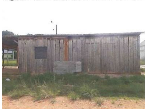
Figura 6 - Barracão de obra - nov/2016
