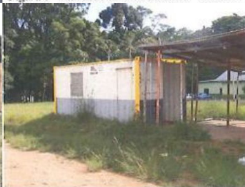
Figura 5 - Barracão de obra - nov/2016
