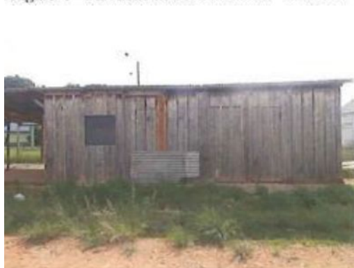
Figura 6 - Barracão de obra - nov/2016
