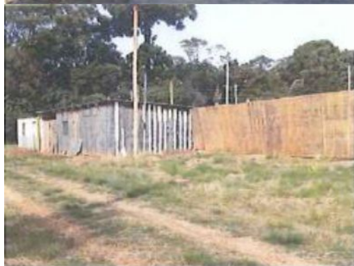
Figura 4 - Barracão de obra invadido - mai/2017
