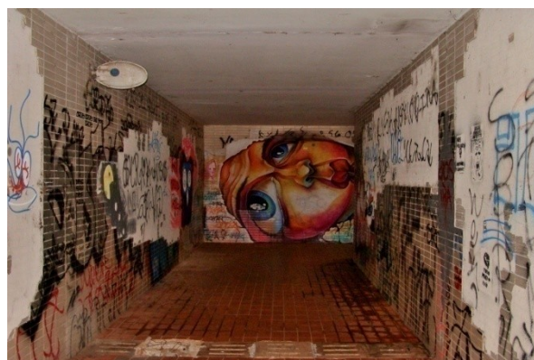
Passagem subterrânea das SQN 115/215.
